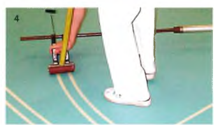
Abb. 2: Die Lastverteilerplatten werden vollflächig verklebt
